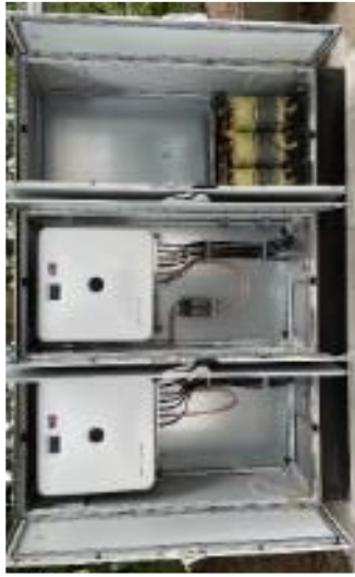
Netzbildende Wechselrichter der Firma SMA mit 100 kW elektrischer Leistung
