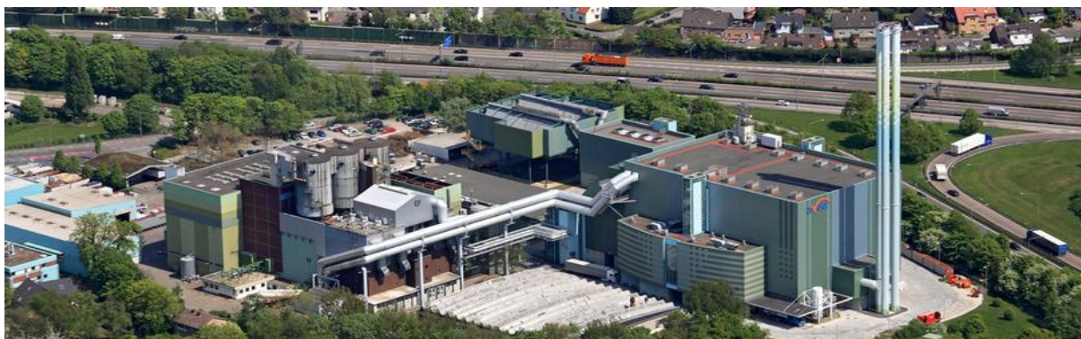
Abbildung 7.4: Müllheizkraftwerk der AVEA
