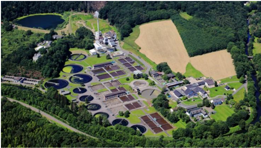
Abbildung 1.1: Kläranlage Buchenhofen (Foto: Wupperverband)
